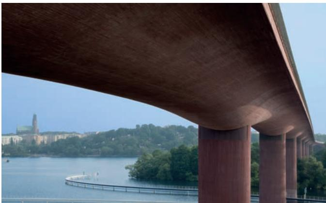
A aplicação do concreto foi realizada em seções em uma plataforma de 130m, que foi unida às seções já finalizadas, e depois montadas em duas colunas de sustentação. A fim de evitar variações grandes na cor, as tábuas de madeira das formas foram cobertas com mistura de cimento de pigmentação vermelha. A aplicação de 24 horas foi contínua, com mais de 300m<sup>3</sup> de concreto bombeado na forma.
