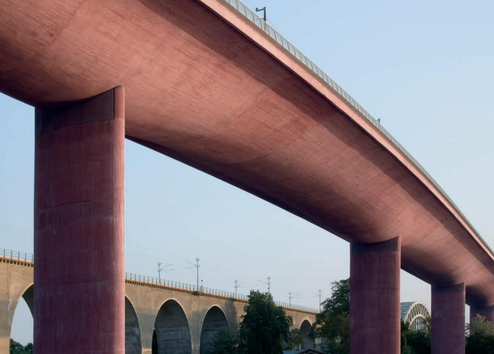
**Para a coloração marrom avermelhada do concreto, 350t de pigmento de óxido de ferro foram usadas em uma mistura especial tendo como base o Bayferrox® 640.**
